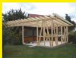
Garage, Carport, Freisitz...
